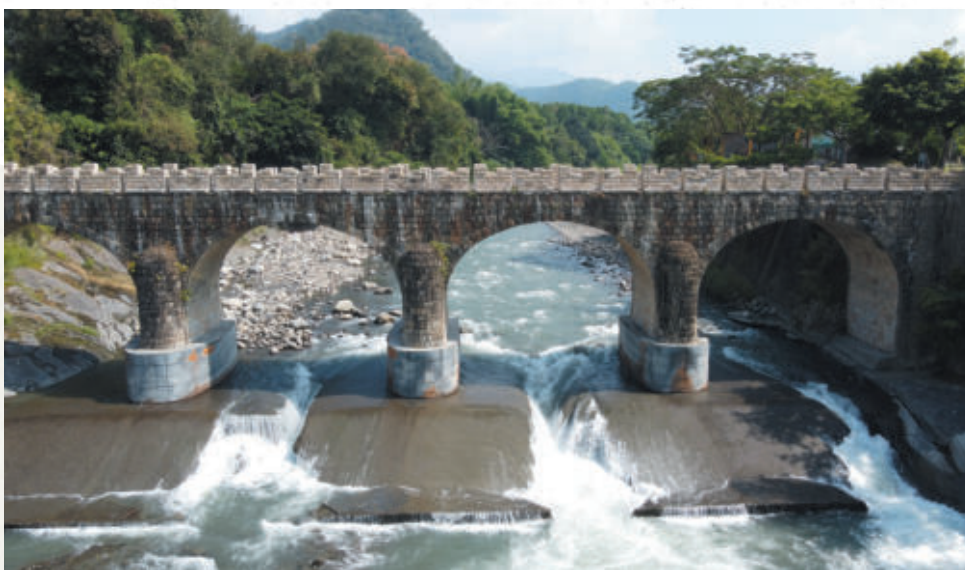
● 當地古蹟糯米橋運用石灰、糯米、紅糖等材料建成，距今已有 80 多年歷史
